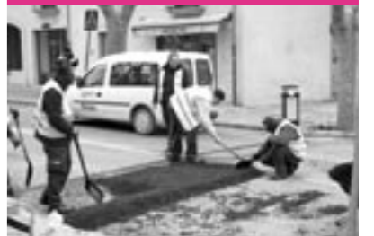
Moment de la construcció del ressalt
