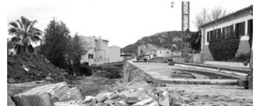
Inici de la demolició de l'antiga piscina
